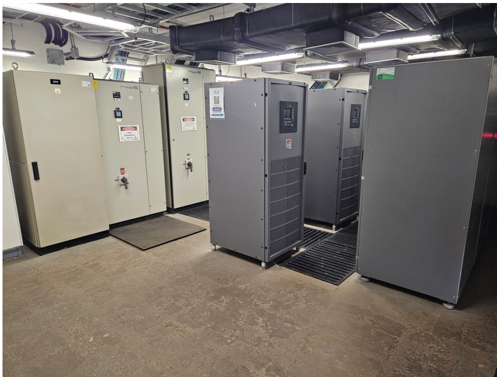
Figura 21 – Sala X do Prodasen, com 4 nobreaks instalados
