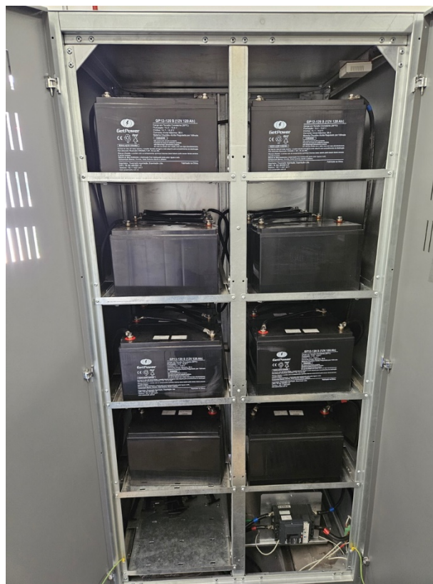
Figura 7 - Visão do banco de baterias aberto
