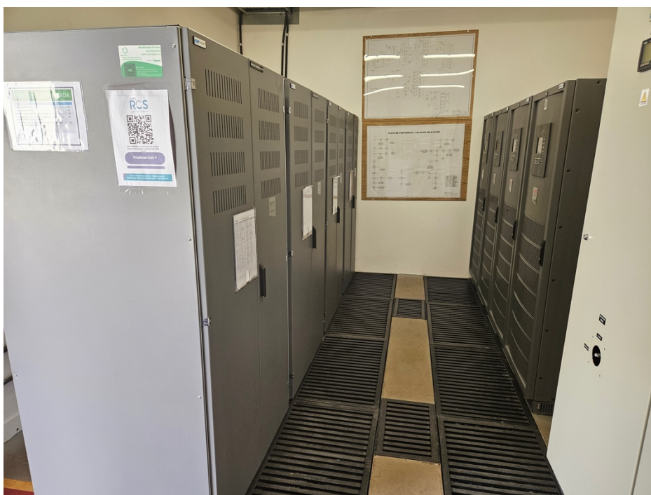
Figura 30 - Nobreaks do Ramal Y - Prodasen
