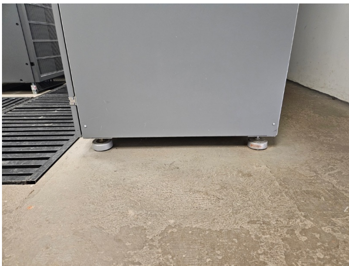
Figura 13 – Pés niveladores para o banco de baterias
