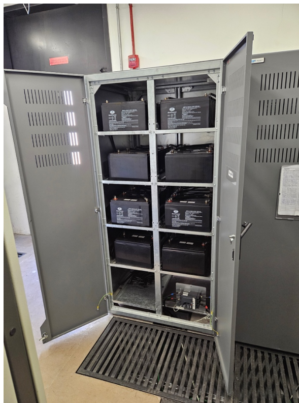
Figura 5 - Visão do banco de baterias aberto
